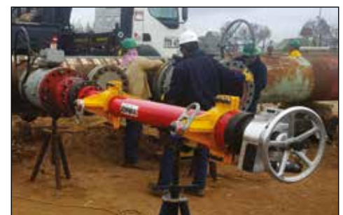
▲ CHT3000 Hot-Tapping-Anwendung für Installation von petrochemischen Rohrleitungen.
