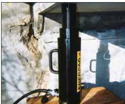
◀ Die tragbaren RACL1506 Zylinder mit Sicherungsmutter dienen zur langfristigen Lastaufnahme bei der Epoxideinspritzung im Rahmen der Brückenverstärkung.
