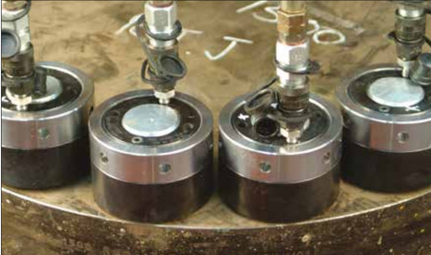
▲ Vorspannen mit Hydraulikmuttern.
