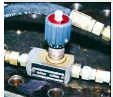
■ Rohrleitungsmontage eines VFC-1-Stromregelventils.
